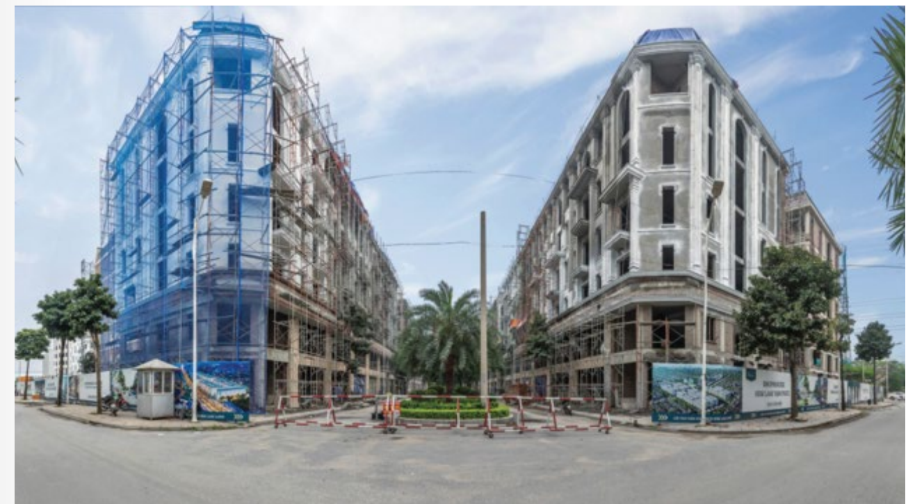
Các căn shophouse tại Him Lam Vạn Phúc đang được xây dựng. Ảnh: Him Lam Land.
